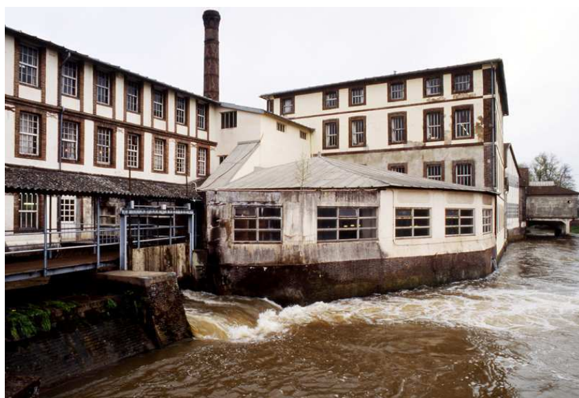
Le principal atelier de fabrication et le déversoir.
