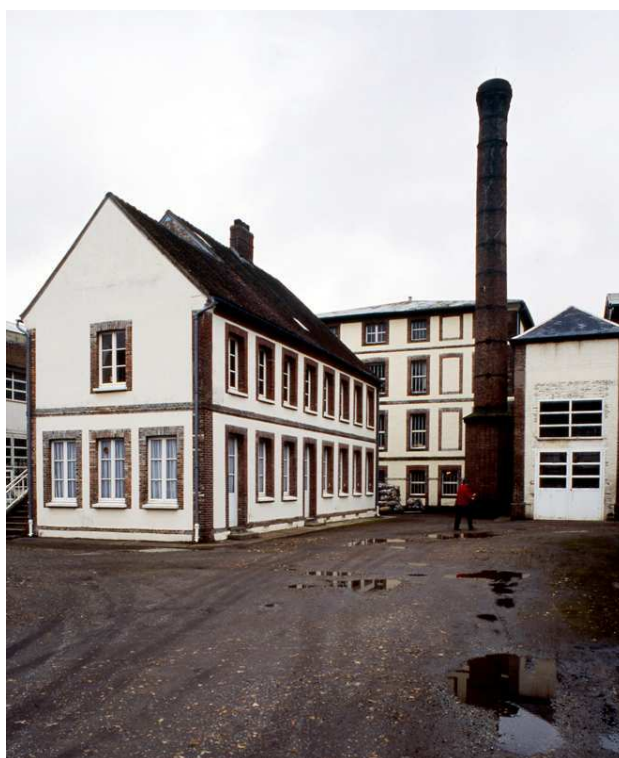
Usine Bohin, bureau, cheminée d'usine, chaufferie et atelier de fabrication.
