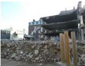
Nouvelle étape clef dans l'avancement de l'opération du "parking des Emmurées". Après plus de 3 mois de désamiantage sous confinement, la déconstruction du bâtiment a
